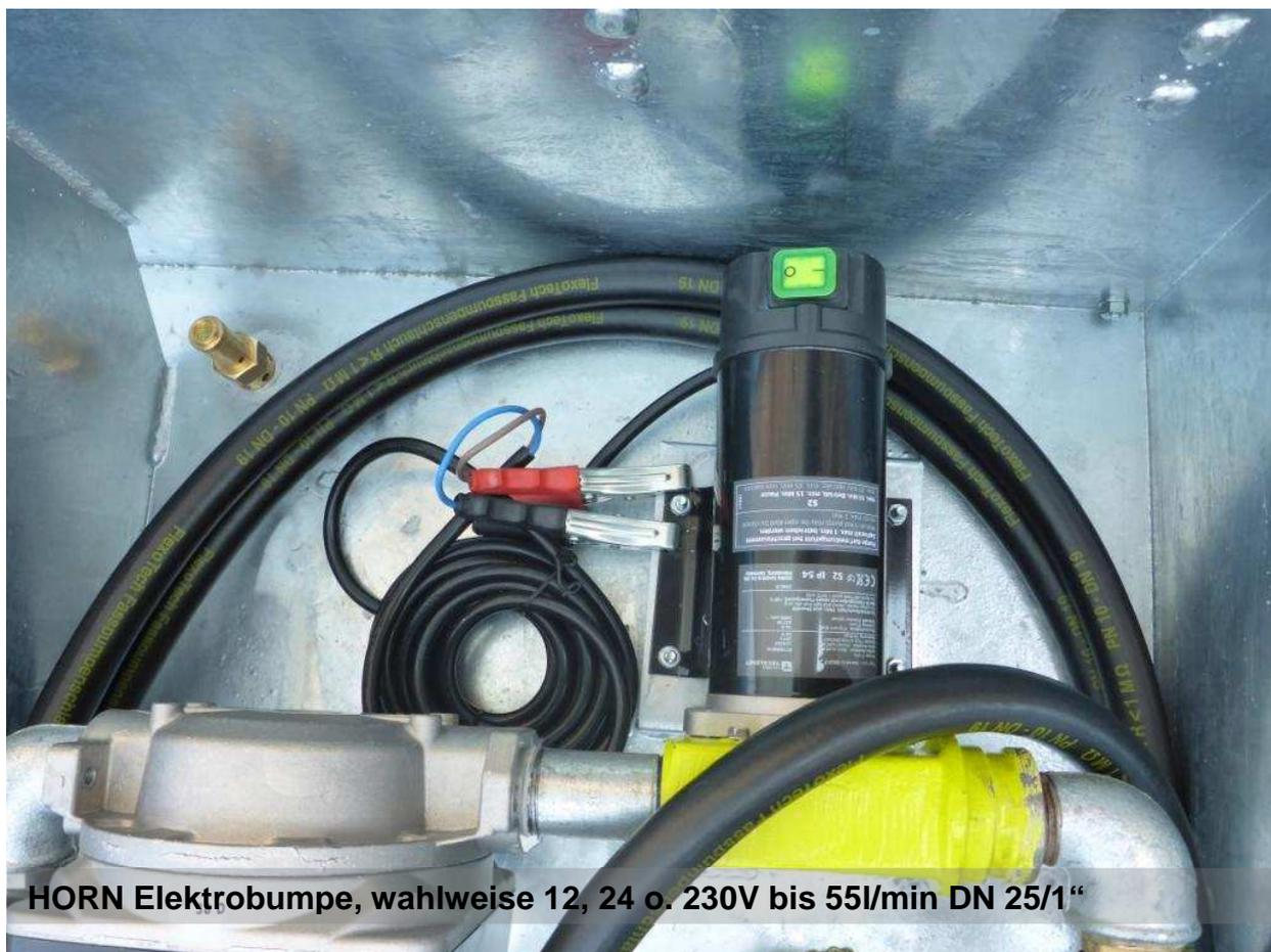
HORN Elektrobombe, wahlweise 12, 24 o. 230V bis 55l/min DN 25/1"
